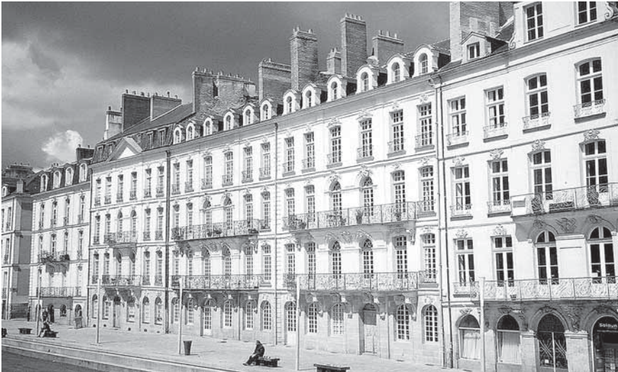
14 – Allée Turenne à l'île Feydeau ; sur un soubassement en granite, mise en œuvre du tuffeau du Val de Loire et du calcaire de Charente ; au premier plan, succession de bancs en migmatite verte polie
