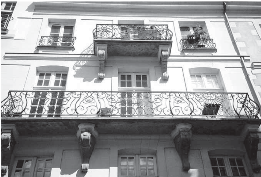
16 – Rue de Kervégan à l'île Feydeau ; appel au sombre calcaire-marbre de Sablé
