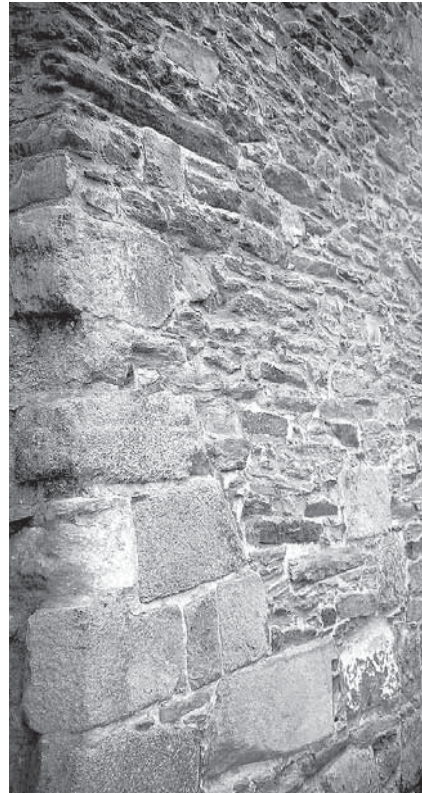
2 – La porte Saint-Pierre a fait un large appel aux micaschistes en moellons hétérométriques ; chaîne d'angle en granite
