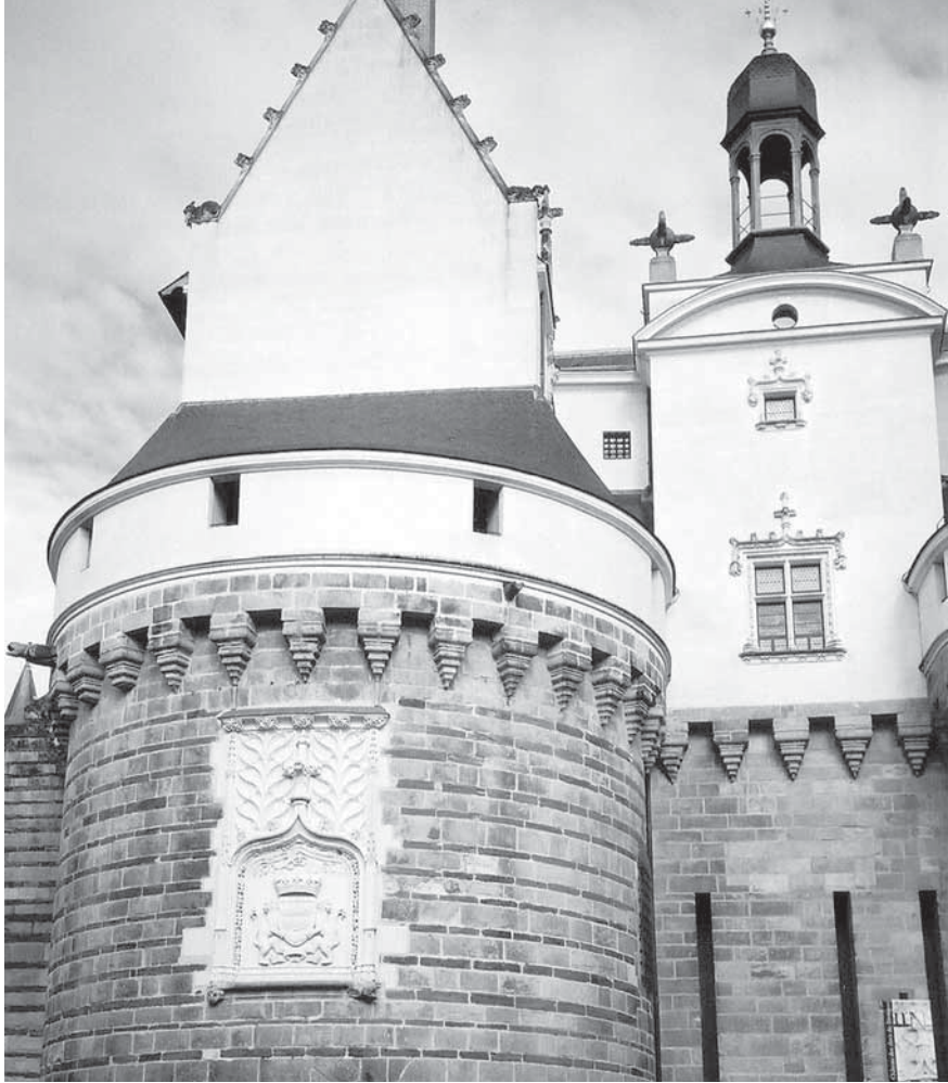
17 – Sur l'une des tours jumelles à l'entrée du château, en alternance micaschiste-granite, blason restauré en calcaire charentais de Saint-Agnant
