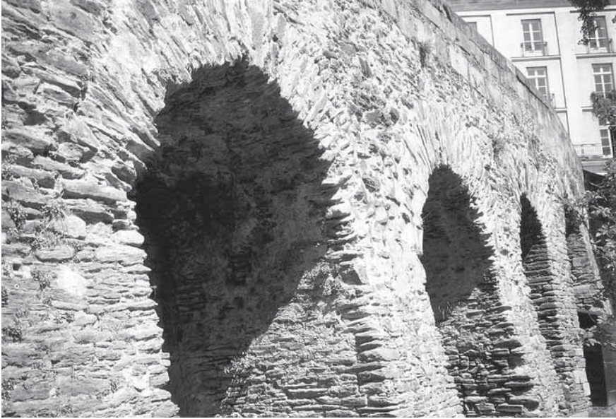
3 – Moellons hétérométriques de micaschistes dans le puissant soutènement à proximité du château
