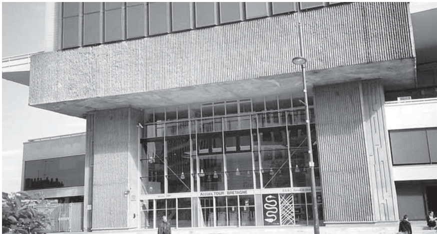
18 – À Nantes, le béton se substituera-t-il à la pierre ? Base de la Tour de Bretagne...
