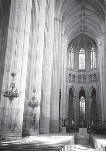
5 – Dans la cathédrale, la partie basale des piliers est en granite de teinte plus sombre que le clair calcaire qui les surmonte
