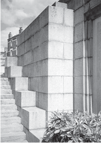
12 – Vue latérale du monument aux morts de la guerre 1914-1918 (« Les Tables ») en leucogranite de Nantes
