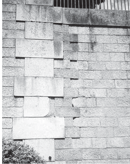
9 – Chaîne harpée en leucogranite de Nantes dans le mur de soutènement de la rue Ceineray, à proximité du tunnel de l'Erdre ; de part d'autre, granite plus sombre en provenance présumée du massif de Louvigné-du-Désert
