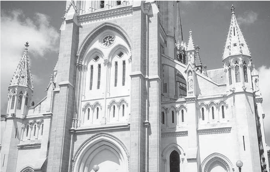
7 – Façade occidentale de l'église Saint-Nicolas ; utilisation du granite (de nuance plus sombre que celle des calcaires) pour les contreforts de la tour
