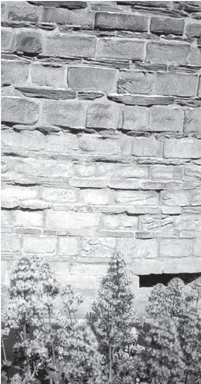
1 – Aspect caractéristique des murailles du château des ducs de Bretagne, alternance réglée d'une assise en longs moellons plats micaschisteux et d'une assise en gros moellons trapus granitiques, reflétant la mise en œuvre esthétique des deux pierres locales
