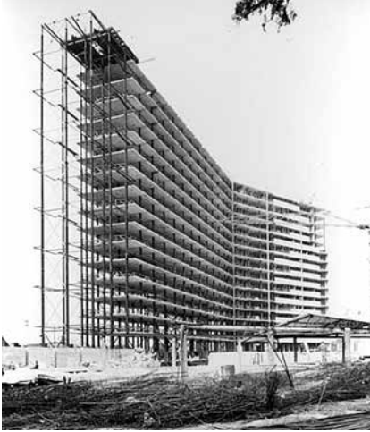
Figure 27 – TOURRY, Georges, Chantier du boulevard Lefebvre : procédé préfabriqué associant une charpente métallique avec des planchers et des panneaux de façade en béton armé, 1964 (Pavillon de l’Arsenal).
