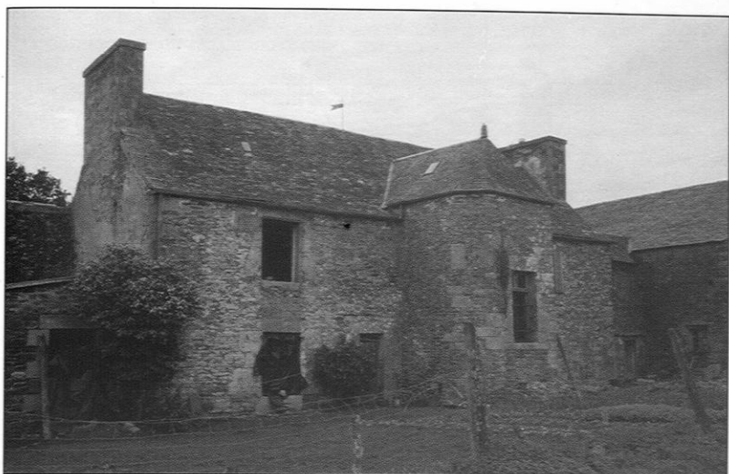
Figure 14. – La maison manale vue du sud-ouest (état de 1981).
