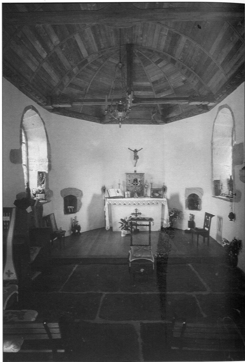
Figure 21. — La chapelle, récemment restaurée et meublée à l'intérieur. La toiture et la charpente sont entièrement neuves. Cliché Gwyn Meirion-Jones
