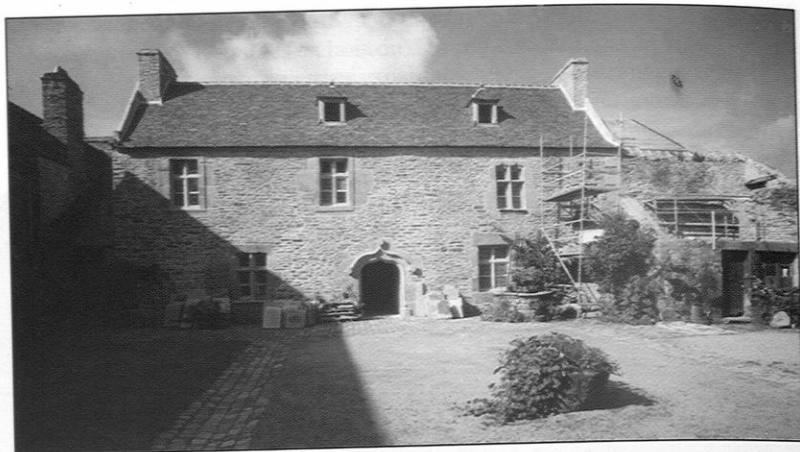
Figure 9. – La maison manale vue de l'entrée de la cour. État pendant les travaux de restauration, septembre 2001. Le style de la porte principale annonce la fin de l'époque gothique. Les encadrements de fenêtre sont à noter. Ceux de la salle haute (à gauche) représentent les modifications de la Renaissance. Celui de la chambre seigneuriale à droite, ainsi que celui de la salle basse, sont d'origine. Les lucarnes de la toiture datent de la rénovation actuelle.
