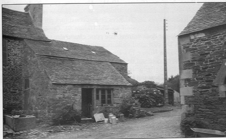
Figure 13. – Les anciens bâtiments annexes
