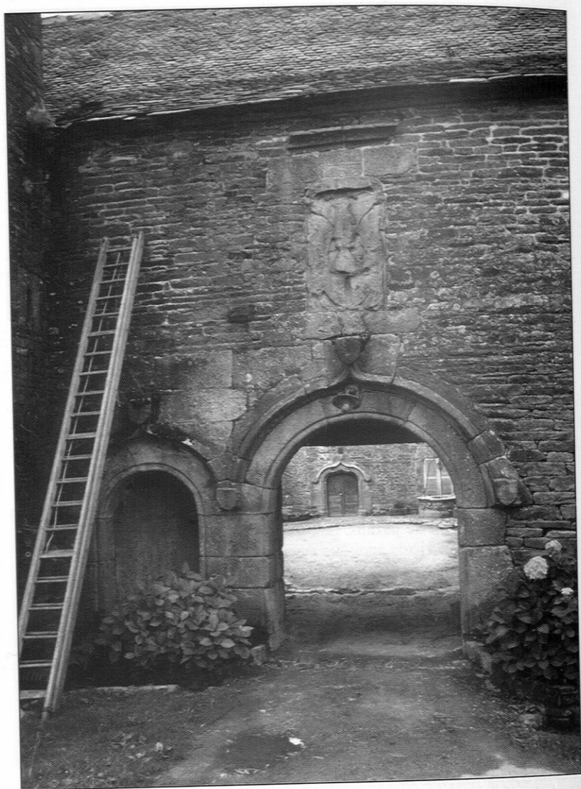
Figure 11. – La porte charretière et la porte piétonne du logis-porche (état de 1981). La porte principale de la maison manale, ainsi que le puits, se voient au fond de la cour. Au-dessus de l'entrée, les anciennes armoiries (martelées) surmontées d'une date gravée de 1558.
