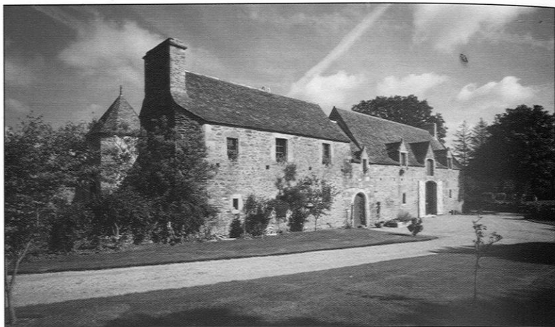
Figure 16. – La rangée ouest, comprenant un logis secondaire (avec ancienne boulangerie au côté nord), suivie par l'ancienne entrée de la cour. Plus loin, l'ancienne grange, récemment transformée en pièce de réception au rez-de-chaussée, avec des chambres à l'étage
