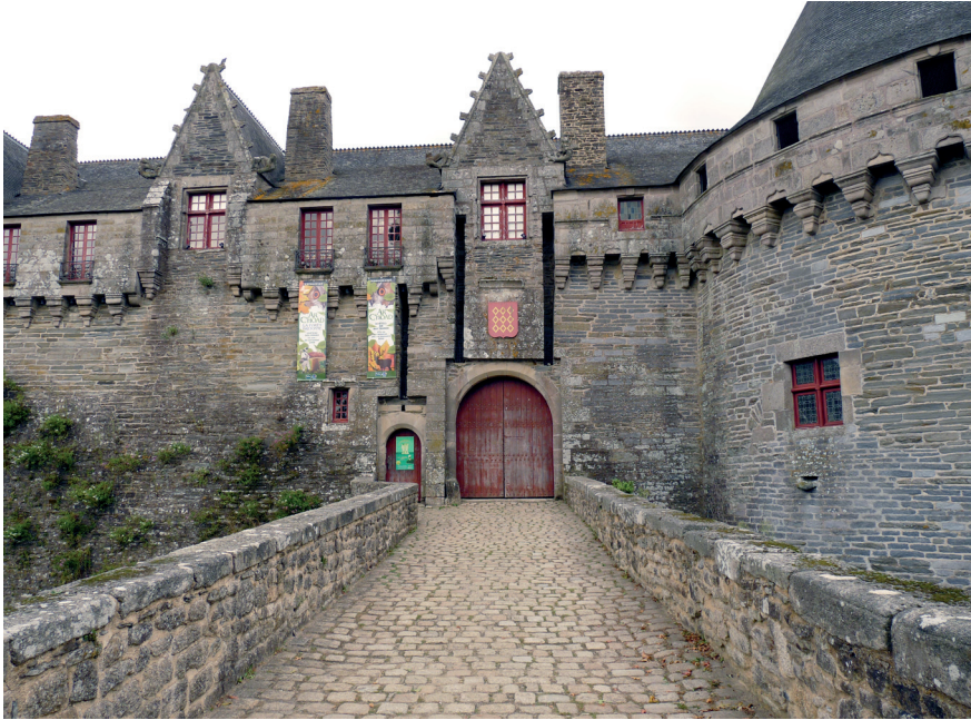
Figure 8 – Pontivy, vue de la façade externe du portail d'entrée et de ses trois rainures verticales (cl. Jocelyn Martineau, 2009)
