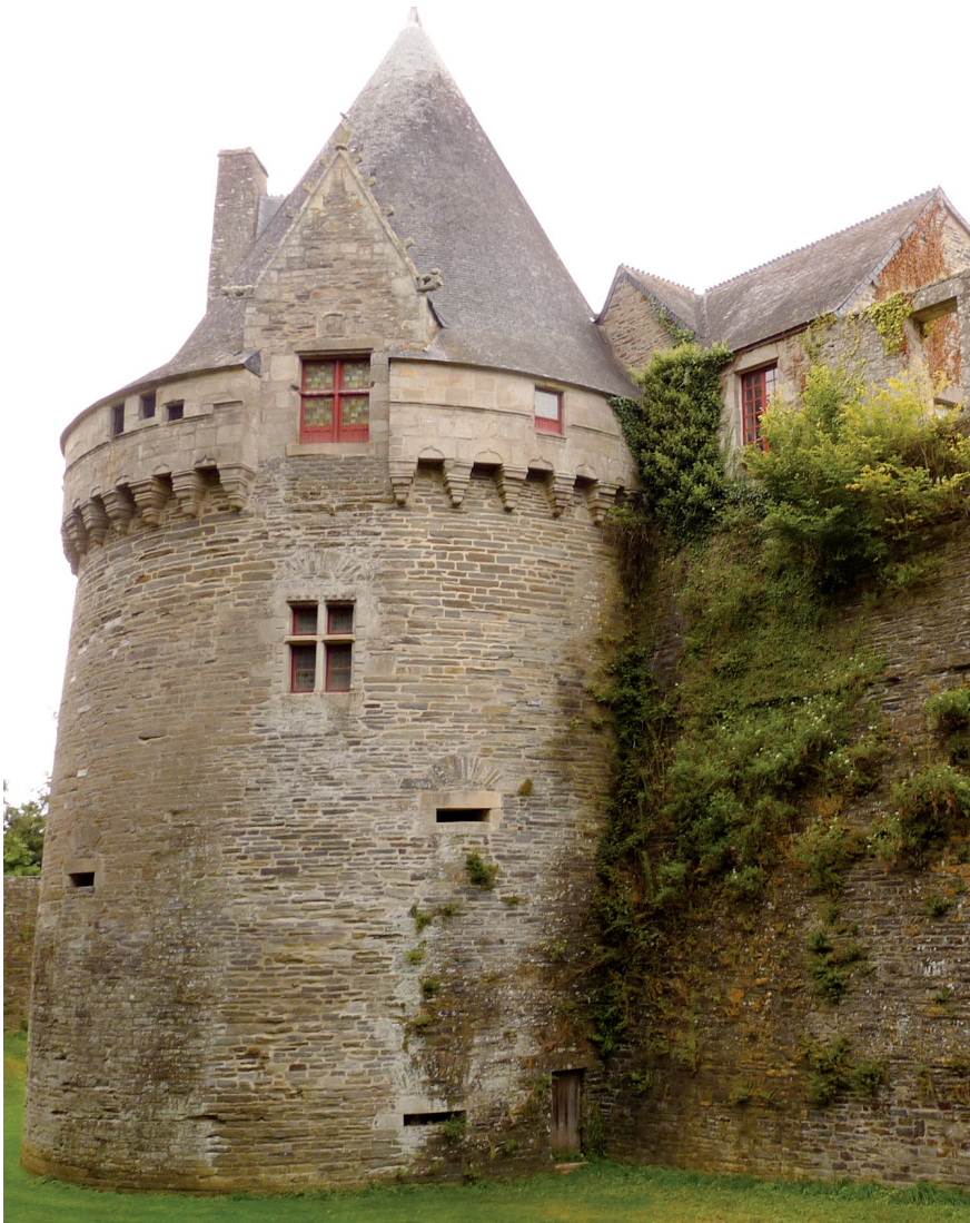
Figure 6 – Pontivy, vue de la tour sud-ouest, de la poterne latérale en fond de fossé et de ses deux niveaux de canonniers à la française (cl. Jocelyn Martineau, 2010)
