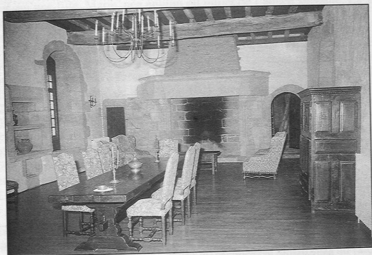
Figure 14 – Coadélan : la salle haute en 1987. A noter le plafond inséré vers 1660, la cheminée dont la hotte se retrécit et la crédence au mur latéral. A la droite de la cheminée une porte conduit à la chambre seigneuriale, à gauche une petite porte donne accès à la petite tourelle d'escalier.
