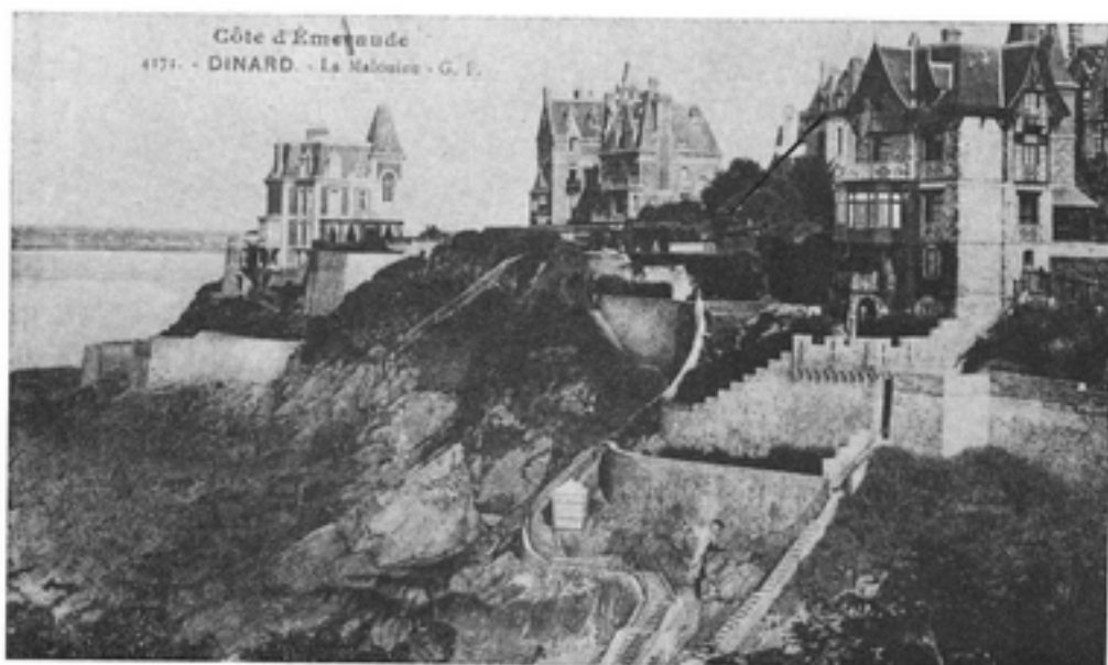
FIG. 4 - Dinard, La Malouine - Etagement des villas sur les rochers A l'extrême gauche, villa « Les Roches-Brunes », de type Louis XIII Au centre, maison à souche de cheminée à l'anglaise
