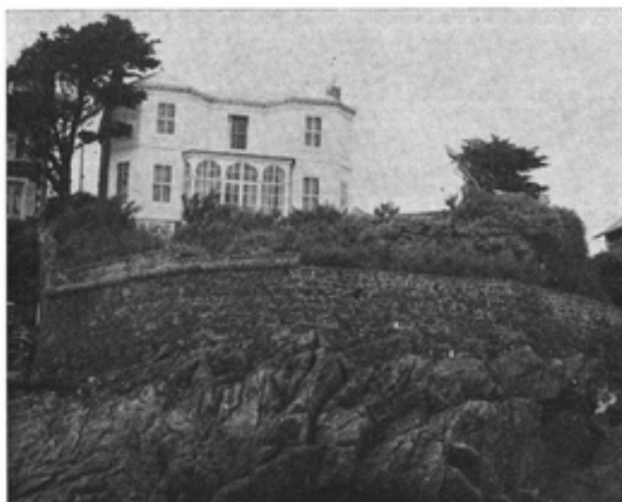
FIG. 5 - Paramé Pointe de Rochebonne Maison à véranda, arcs outrepassés d'inspiration orientale
