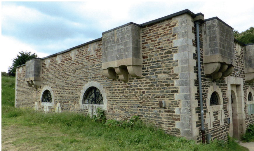
Figure 3 – Réduit de la Ville-ès-Martin, moellons assisés en amphibolites-pyroxénites rubanées ; pierres de taille des corbelets, de la base des chaînes d'angle et de la porte, en granite ; meurtrières et ouvertures en arc, en calcaire (cl. L. Chauris)
