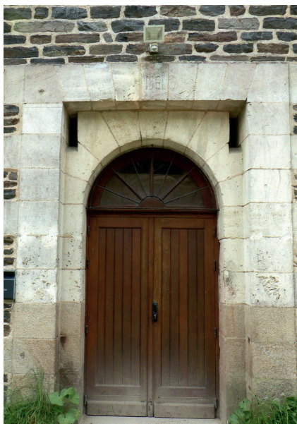
Figure 4 – Entrée du réduit de la Ville-ès-Martin : granite, puis calcaire portant le millésime 1861 (cl. L. Chauris)
