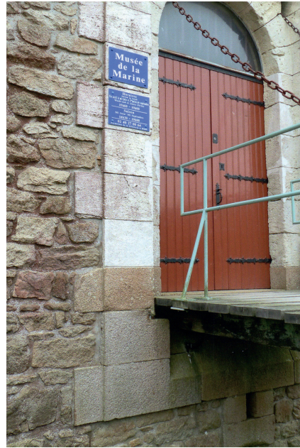
Figure 6 – Entrée du réduit de Mindin. Trois assises basales en granite surmonté par le calcaire blanc, rugueux. Moellons hétérométriques de l'élévation en granite (cl. L. Chauris)
