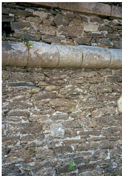
Figure 5 – Parapet de la batterie de la Ville-ès-Martin, moellons en gneiss migmatitiques (cl. L. Chauris)
