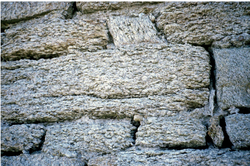
Figure 2 – Batterie de la Barrière, leucogranite feuilleté, proximal, en moellons disposés à plat, ou rarement, de chant (cl. L. Chauris)
