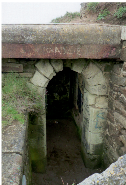
Figure 12 – Fort de l'Ève, porte cintrée en calcaire (cl. L. Chauris)
