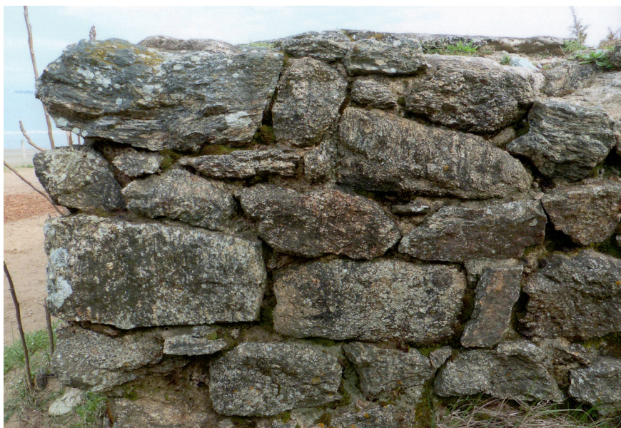
Figure 9 – Batterie du Pointeau, moellons de gneiss migmatitique (cl. L. Chauris)
