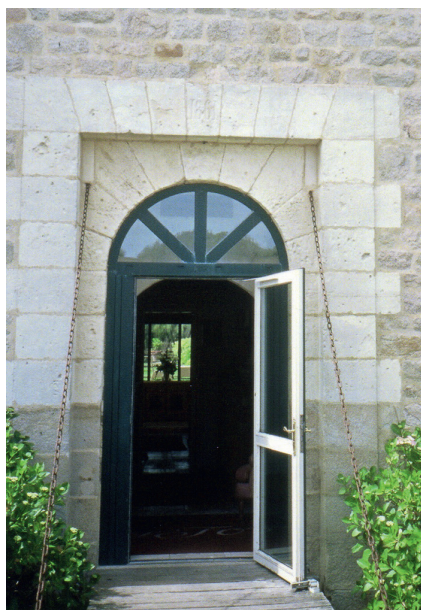
Figure 11 – Réduit de La Pointe, partie inférieure de la porte en granite, partie supérieure en calcaire (cl. L. Chauris)
